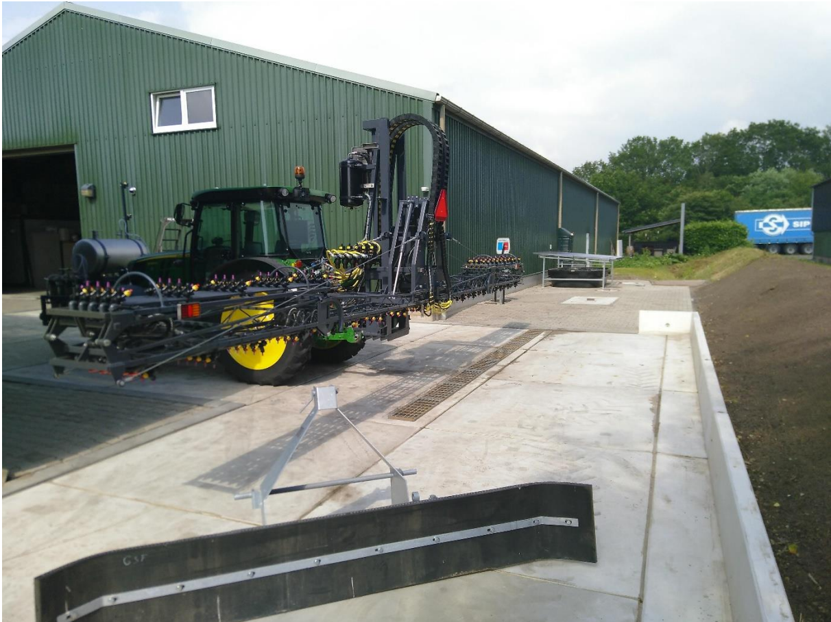
Foto 2 Op deze combi-wasplaats kunnen verschillende machines verantwoord worden gewassen. Waswater dat gewasbeschermingsmiddelen bevat, wordt opgevangen en gezuiverd met een Phytobac. Waswater zonder gewasbeschermingsmiddelen passeert een slibvangput en olieafscheider en wordt op het riool geloosd. Vanaf het erf van dit bedrijf komen geen gewasbeschermingsmiddelen meer in het oppervlaktewater terecht!
